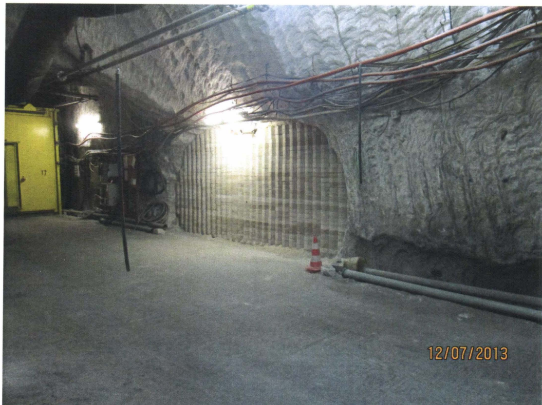
Bild 30: Abgemauerter Eingang „Ponystall“ am Zugang zur nördlichen Richtstrecke n. Osten
